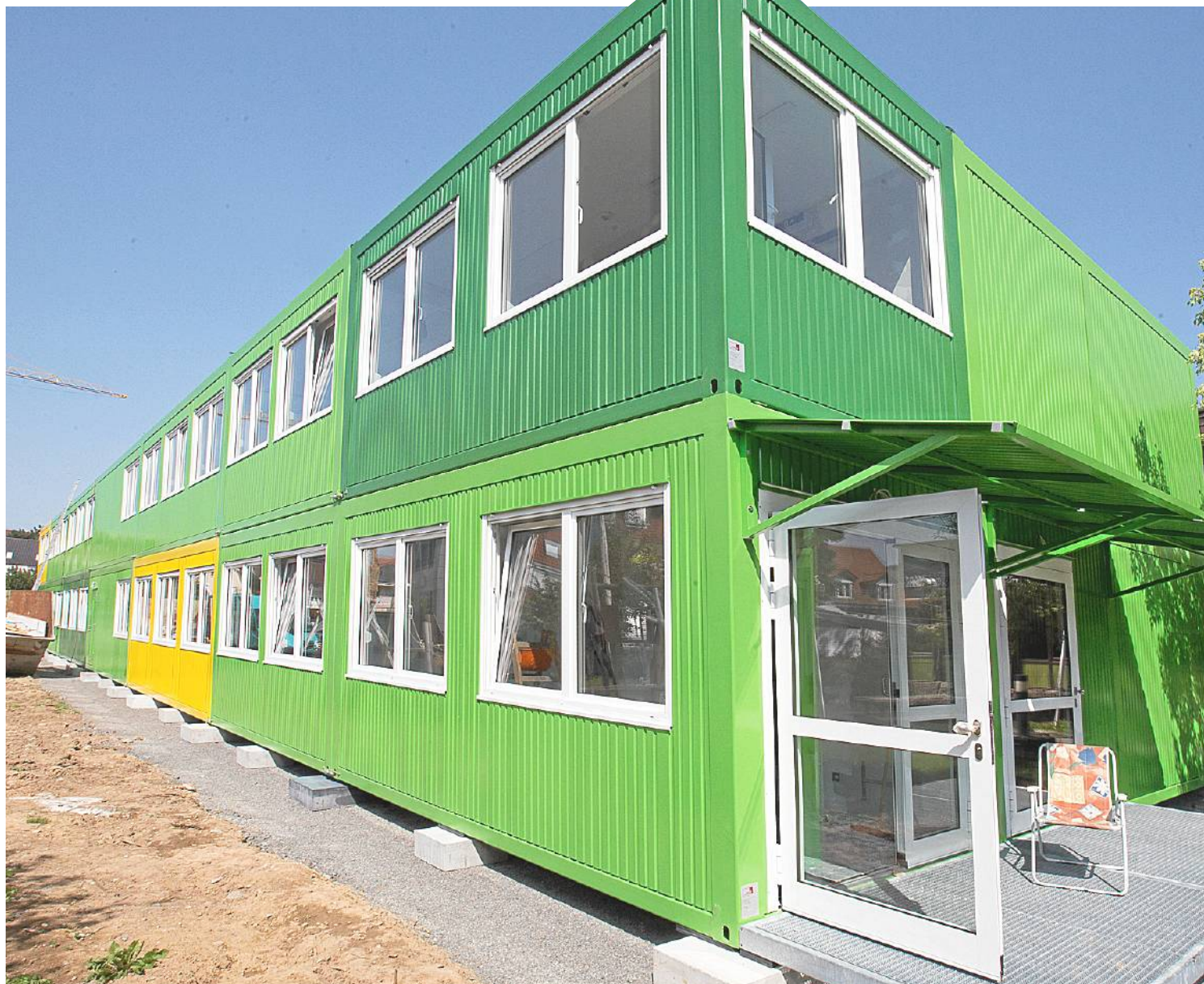
Wo bis vor Kurzem noch die Baracke der Kernzeitbetreuung stand, wurden jetzt farbenfrohe Modulbauten aufgestellt.
